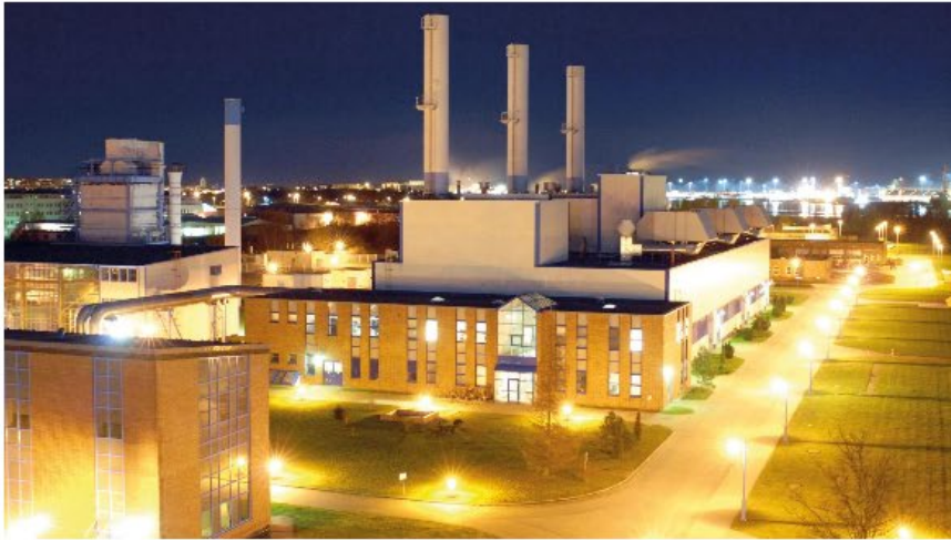
Die Gas- und Dampfturbinenanlage auf dem Betriebsstandort in Marienehe.
