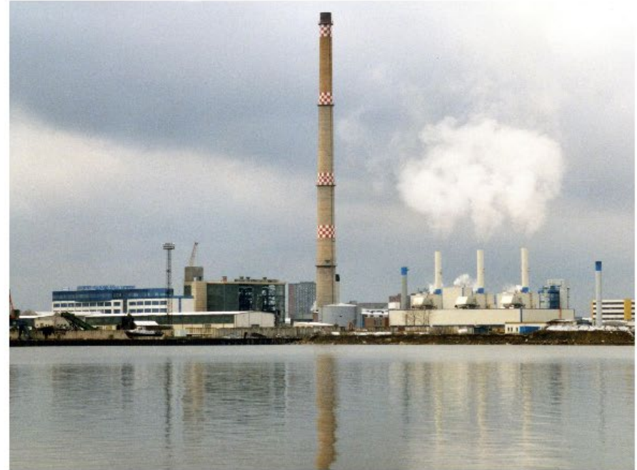
Das alte Heizkraftwerk in Marienehe, 1997.
