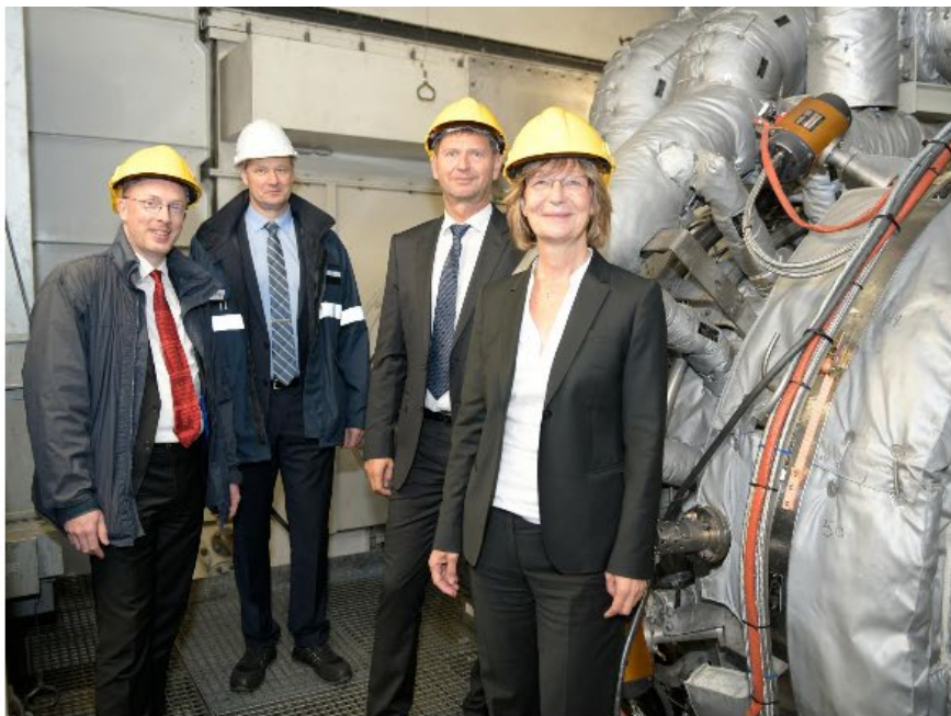
Am 5.10.2017 weiht der Vorstand mit dem Energieminister des Landes, Christian Pegel, die neuen Turbinen ein.
